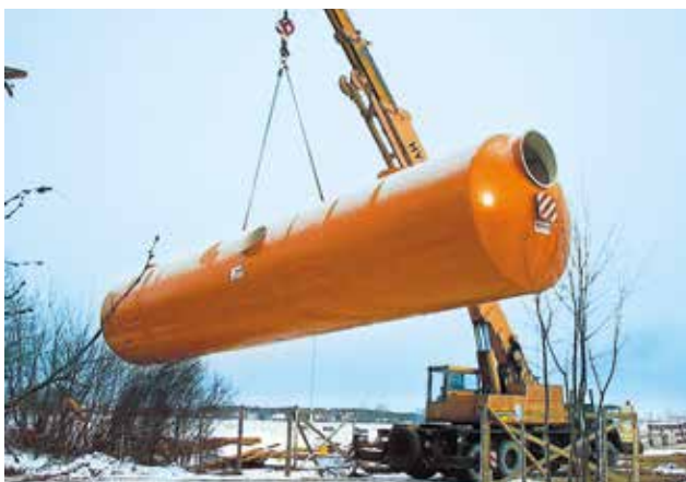
Atskirtuvai gaminami su transportavimo žiedais, palengvinančiais krovas ir montavimo darbus.
